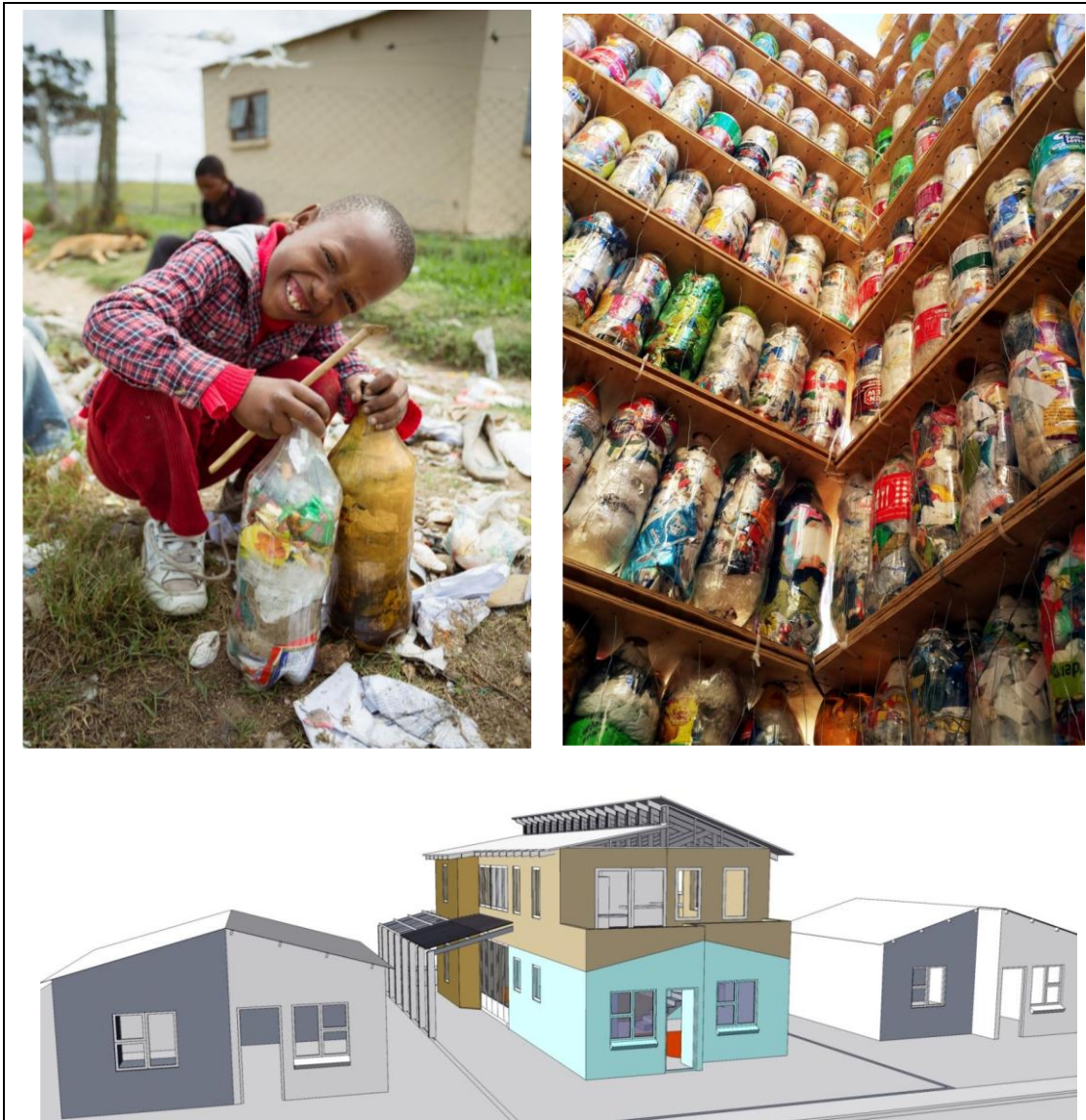
FIGUUR A: Voorgestelde “ Penguins Voorskoolse ”-skool, Walmerdorpsgemeenskap, Port Elizabeth. Die mure is gebou van omgewingsbakstene, gepleister en geverf
